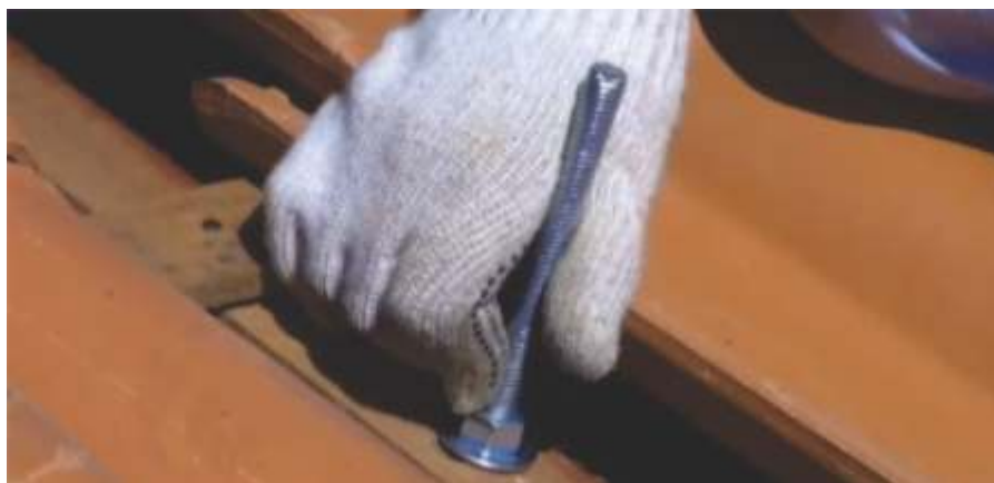
Fixação da barra roscada no caibro auxiliar
