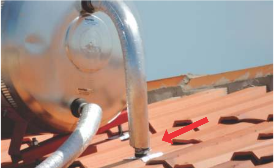
Interligação do tubo de consumo do reservatório térmico na hidráulica da residência
