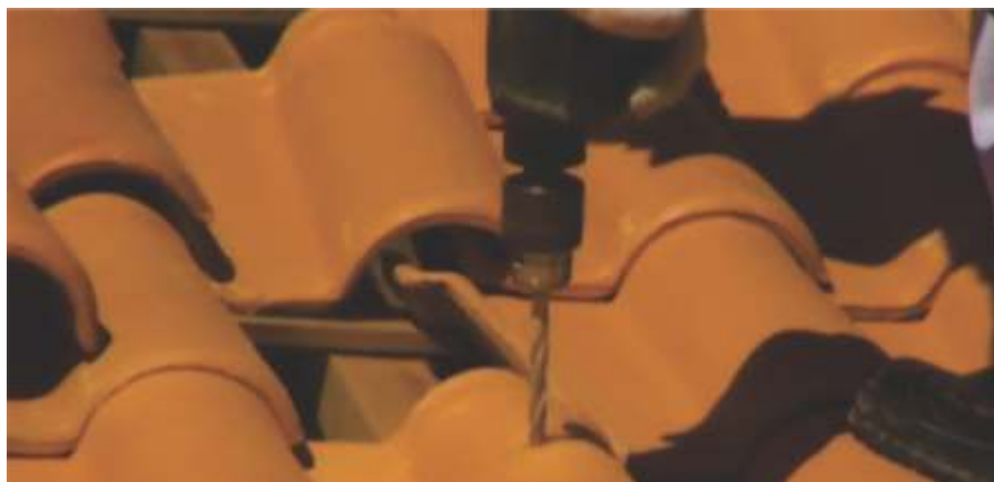
Furo sendo feito em telhado tipo capa
