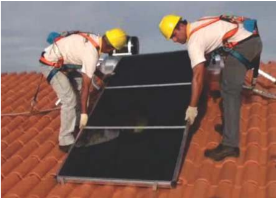
Aquecedor Solar compacto sendo instalado
