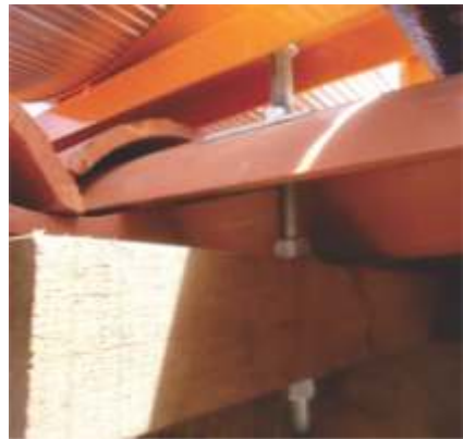
Vista em corte da barra roscada instalada
