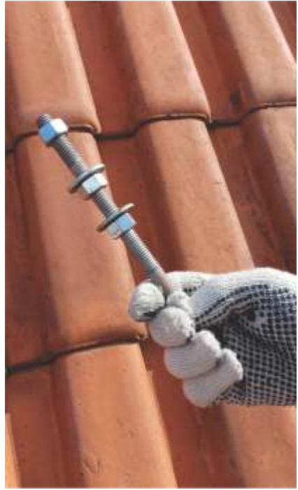
Barra roscada cortada e com porcas e arruelas
