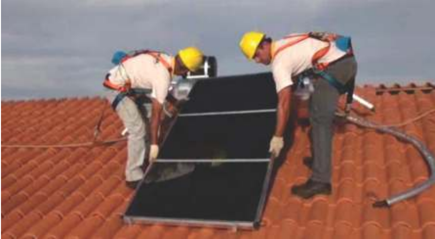
Coletor solar sendo fixado nos suportes sobre o telhado
