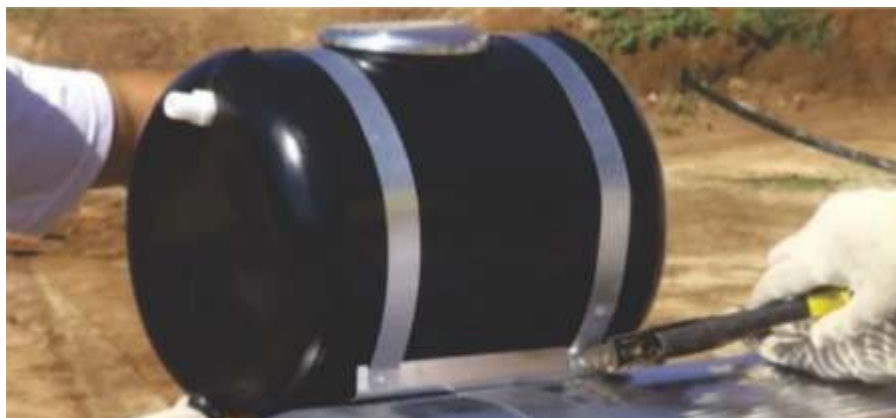
Caixa Quebra-Pressão sendo fixada com rebites
