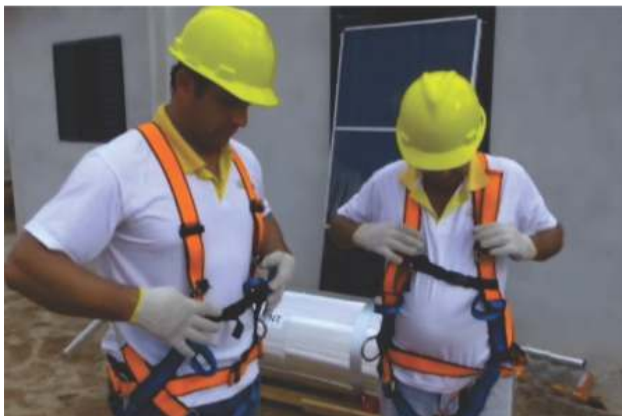
Instaladores com equipamentos de segurança adequados para trabalho em altura
