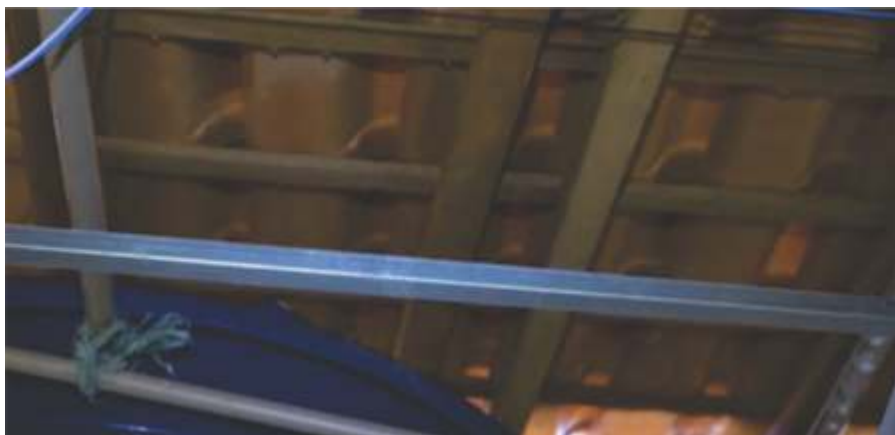
Caibro auxiliar instalado para receber o suporte do RT através da fixação por barras rosçadas
