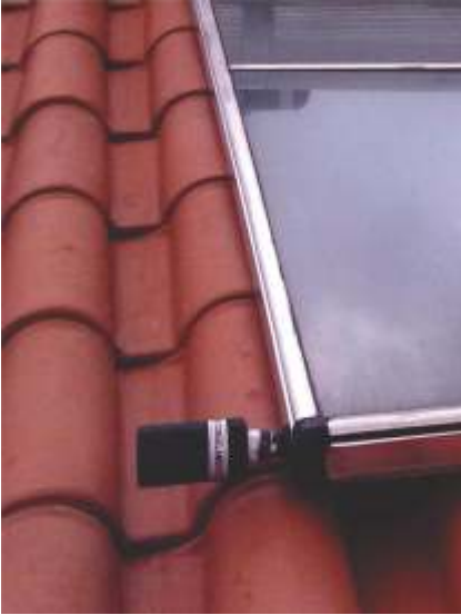
Válvula anticongelamento mecânica
