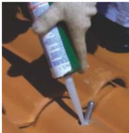
Barra roscada sendo vedada com silicone junto à telha do tipo capa
