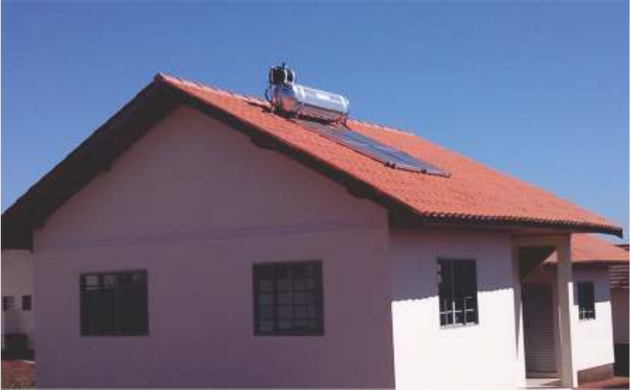
Aquecedor Solar Compacto instalado em orientação e inclinação ideais
