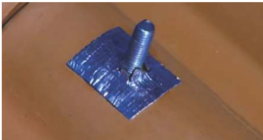
Manta asfáltica colocada por cima do silicone e junto à barra roscada
