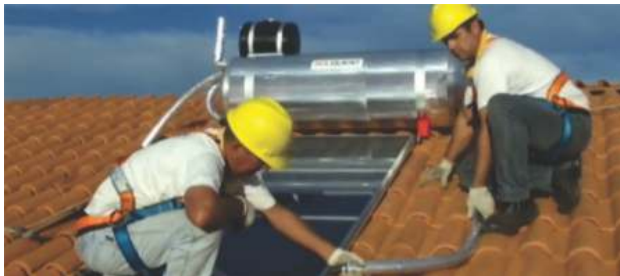
Mangueira sendo fixada no coletor solar
