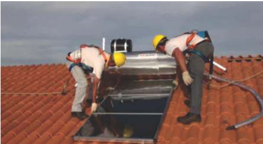
Coletor solar já fixado nos suportes
