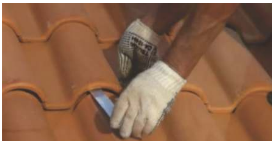
Técnico ajustando a posição do suporte tipo fita metálica no telhado
