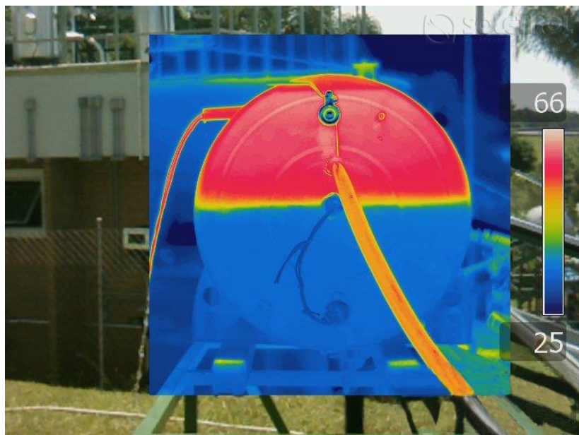
Foto 36 - Imagem infravermelha do reservatório sendo esvaziado a 10 min
