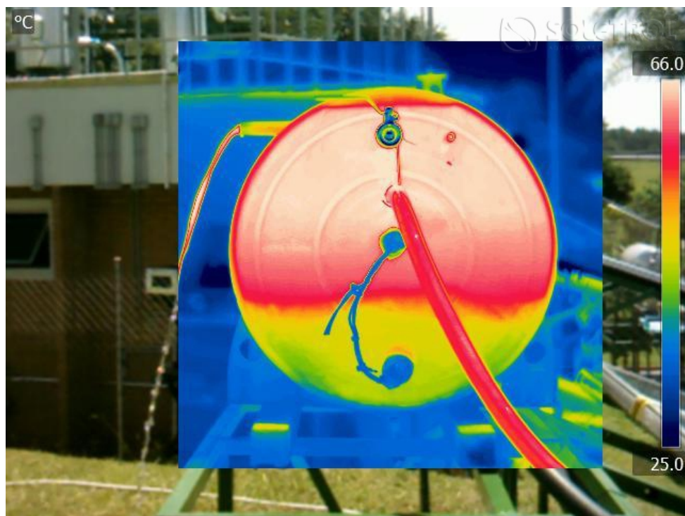
Foto 33 - Imagem infravermelha do reservatório sendo esvaziado a 4 min
